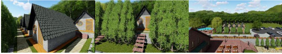
Şekil 15 a,b,c. Bungalov evlerden görünüm
