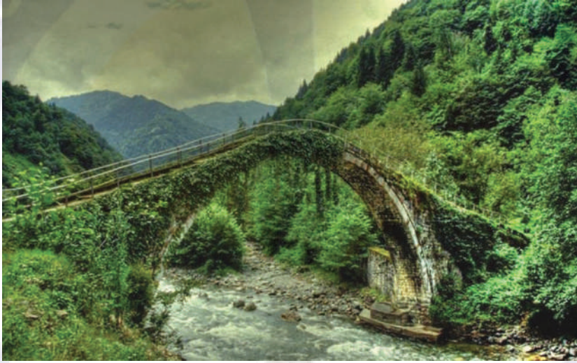
Resim 8. Rize- Çamlıhemşin Şenyuva Köprüsü (Güler, 2012)
