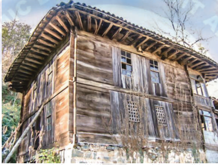
Resim 10. Ahşap yığma sistemle inşa edilmiş bir köy camisi: Meyveli köyü, Fındıklı (Güler ve Bilge, 2013)
