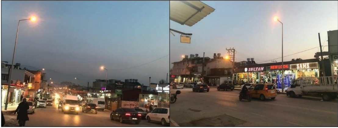
Şekil 10. Şükrü Balcı Caddesi aydınlatma elemanları
