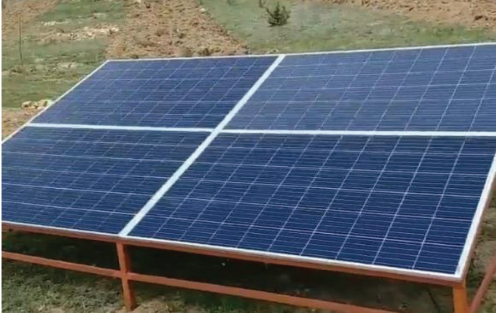
Őekil 4. Tarımsal sulama amaęlı fotovoltaik enerji sistemi: 4 adet 275W gneŐ paneli ve 600W DC dalgıç pompa
